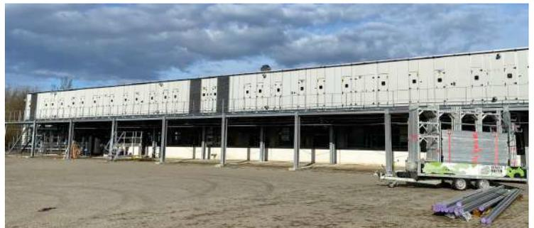
Für eine neue Produktion der Firma Eppendorf in Wismar plant und installiert airpool hochwertige Lüftungsanlagen für Reinräume. Das Life-Science-Unternehmen produziert und vertreibt weltweit qualitätsvolle Systeme für den Labor-Einsatz. Zum Lieferumfang gehört das bisher längste von airpool installierte Lüftungsgerät mit einer Gesamtlänge von 60 Metern und einer Luftmenge von 275.000 m³/h.
