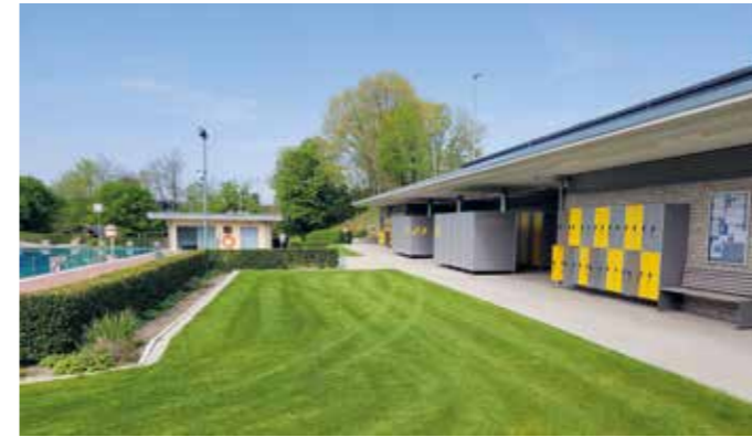
Der neue Bereich mit den Umkleiden und Sanitäranlagen. (Foto: Bernholt)
